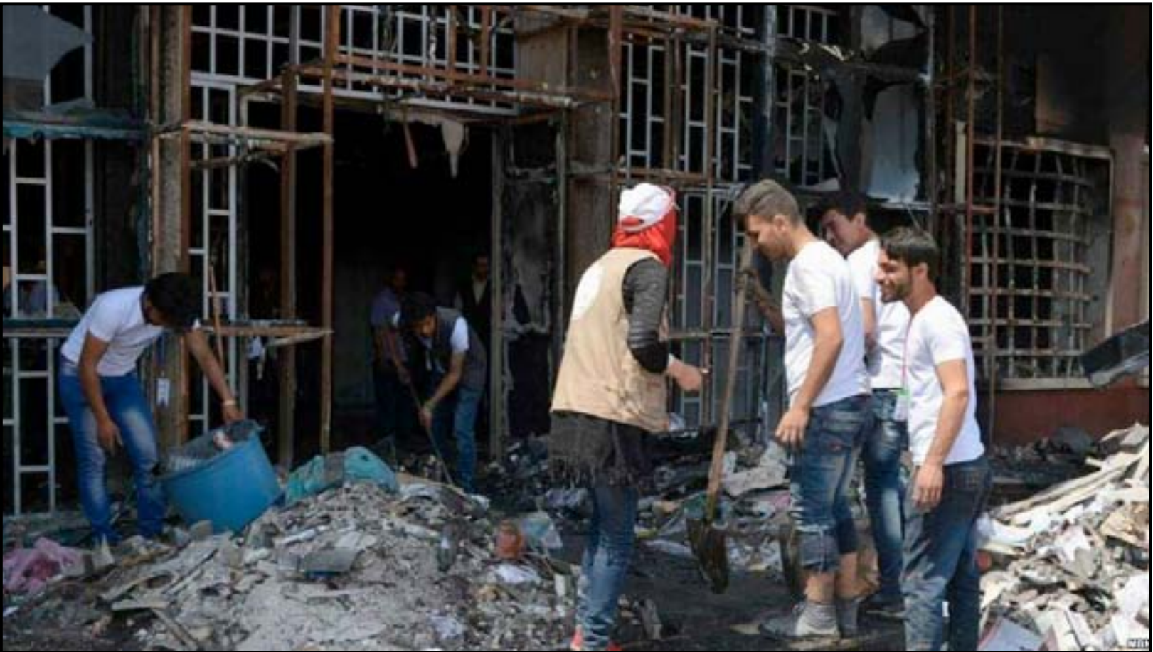
عمال ينظفون مبنى مدمر داخل جامعة الموصل... ارشيف
