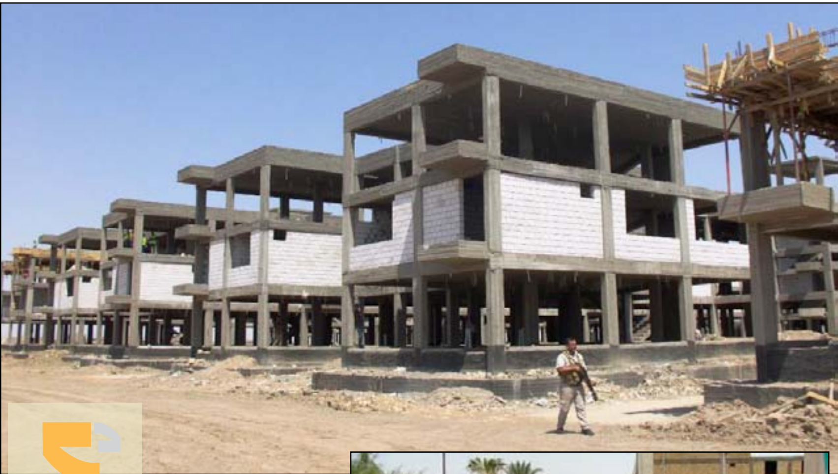
صورة من موقع البناء في محافظة ذي قار
