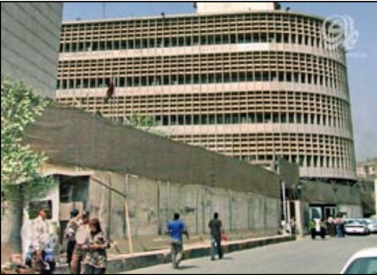
مبنى البنك المركزي
