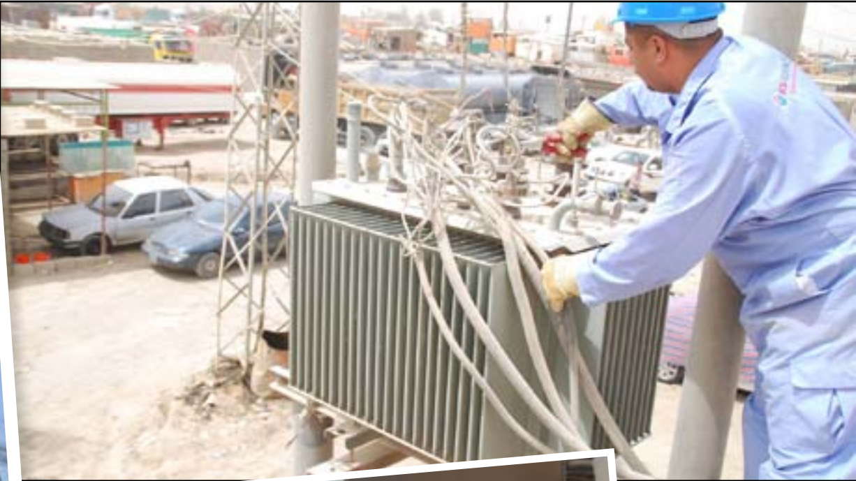
تدبيل محولة لزيادة الفولتية الكوادر الهندسية والفنية في فرع الرصافة الشمالي قامت بحملة للحد من التجاوزات العشوائية
