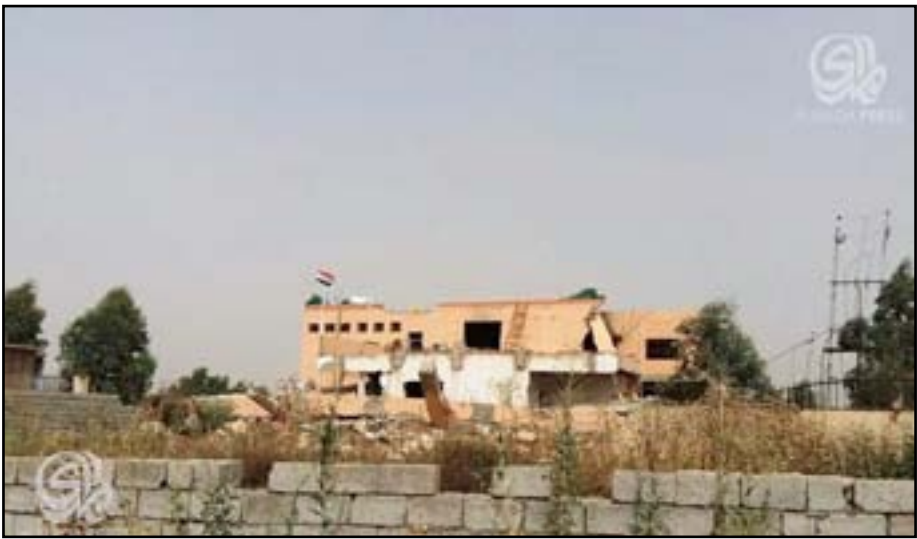
مبنى قائممقامية قضاء بيجي
