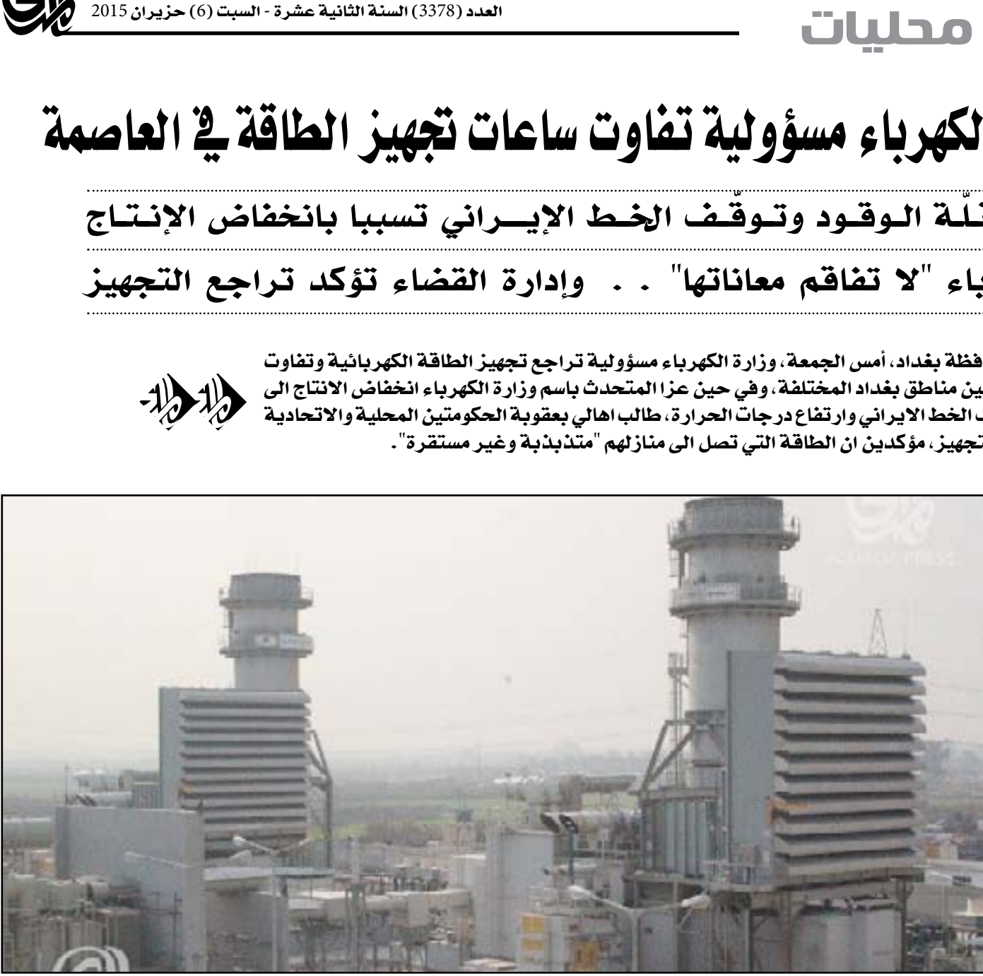
محطة كهرباء القدس الحرارية شمال بغداد
