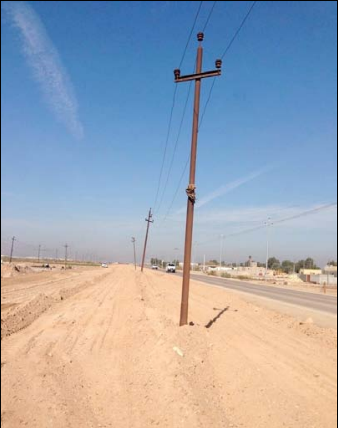
طريق الكحلاء – العمارة معطل بسبب تل أثري وأعمدة كهرياء
