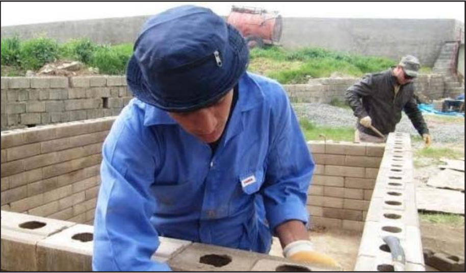
بناء دور تعتمد على خلطة من مادتي الطين والإسمنت تتناسب مع بيئة الأهوار
