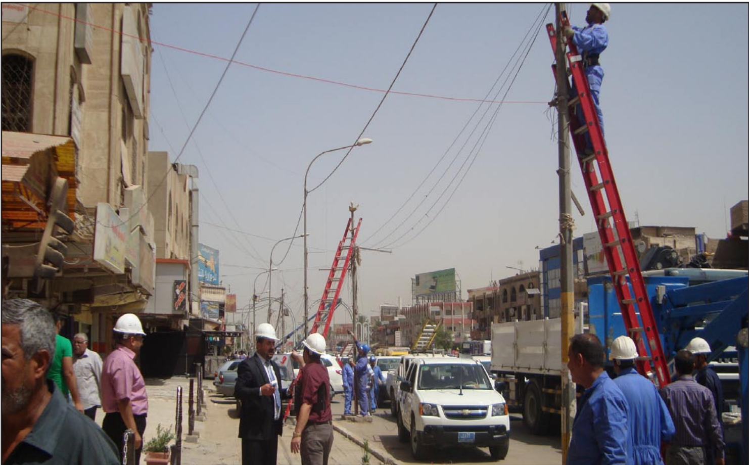
جانب من عملية تصليح موصلات الطاقة الكهربائية
