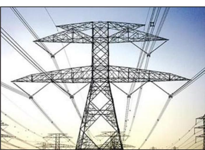
خطوط ناقلّة للكهرباء
