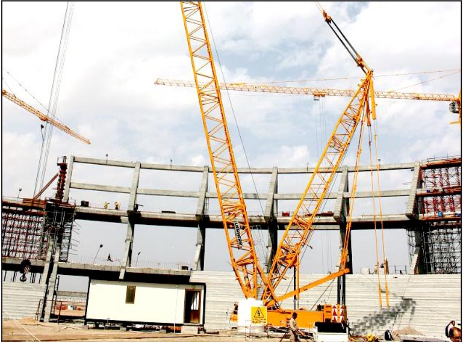
جانب من مشروع انشاء المدينة الرياضية في البصرة
