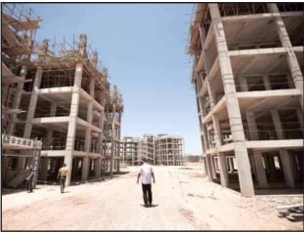
مجمع سكني قيد الانشاء
