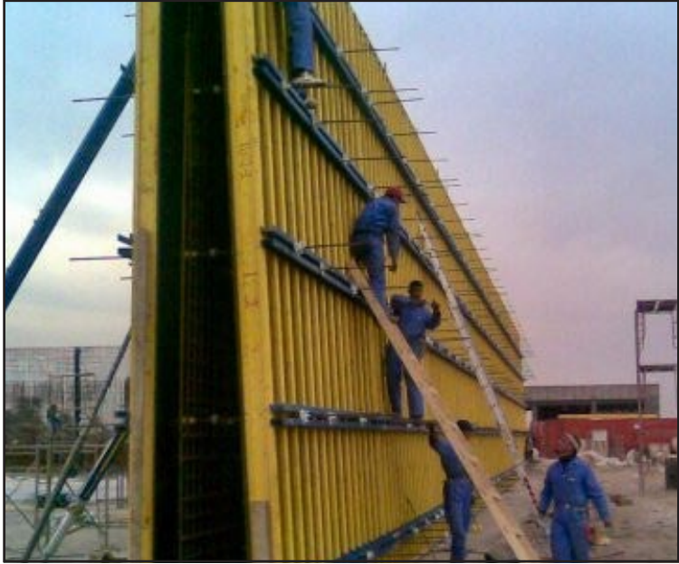
العمال يعملون على تركيب حديد التسليح في جدران الخزانة الأرضية لمشروع ماء الرصافة العملاق في بغداد.
