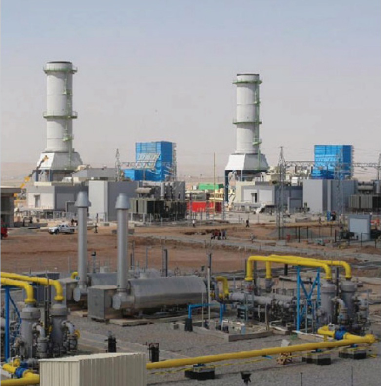
محطة كهرباء في جيمجال
