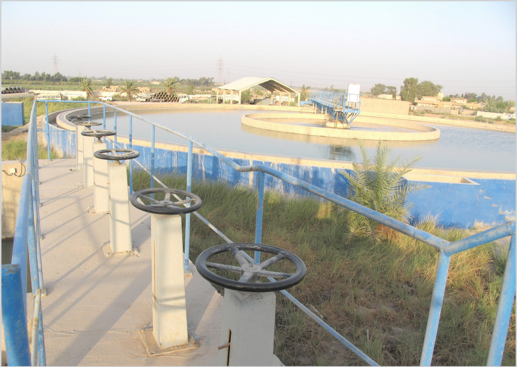
احد مشاريع المياه
